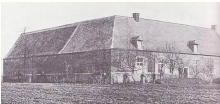
Afbeelding: de Veldonckhoeve vóór 1914. De hoeve werd in 1923 opnieuw opgebouwd 163 .
